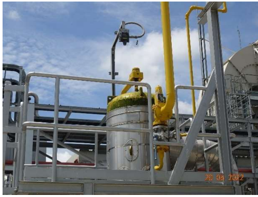
(42) เครื่องตรวจจับการรั่วไหลของก๊าซธรรมชาติ (Gas Detector)
