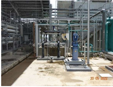
(16) ถังปรับสภาพให้เป็นกลางเพื่อบำบัดน้ำทิ้งจากระบบผลิตน้ำปราศจากแร่ธาตุ
