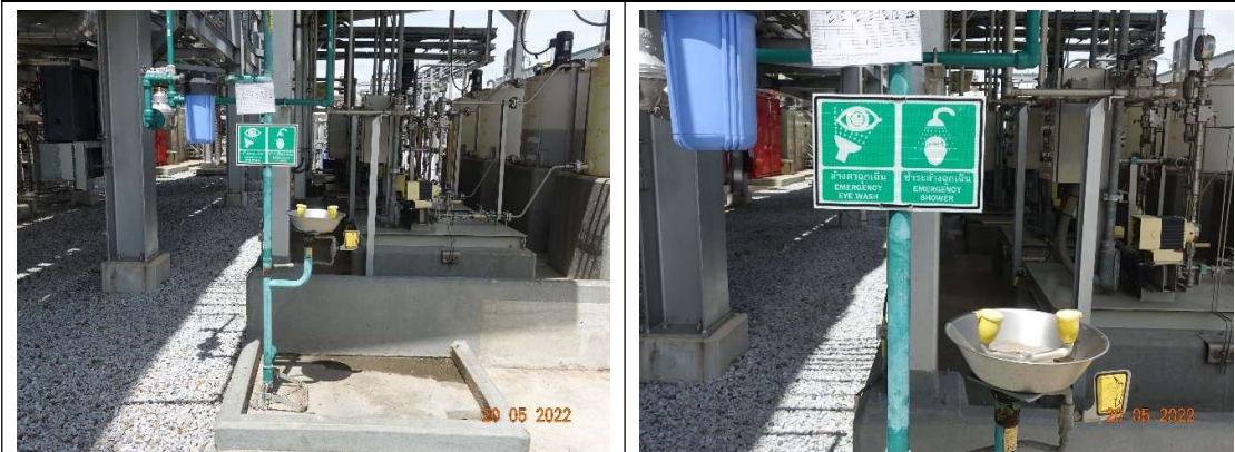
(37) อ่างล้างตาและร่างกายฉุกเฉิน
